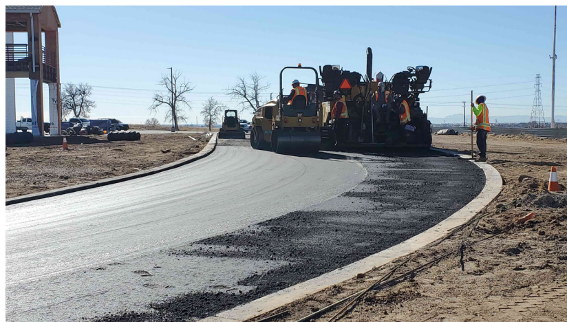
▲ Las mejoras en el flujo de tráfico aumentan la seguridad del sitio para empleados y visitantes.
