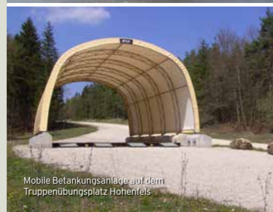
Waschanlage mit geschlossenem Wasserkreislauf auf dem Truppenübungsplatz Hohenfels
